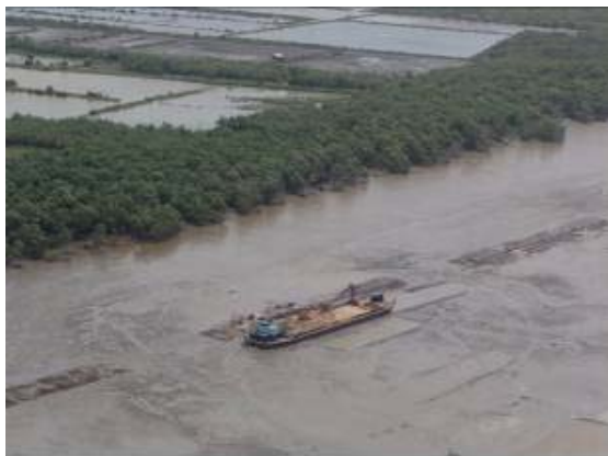
การก่อสร้างโครงสร้างป้องกันกัดเซาะชายฝั่ง
